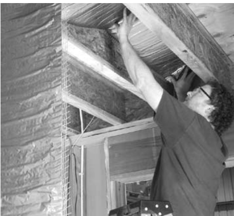
Pruebe encajar la placa entre las vigas antes de sujetar la placa a ellas con ayuda de grapas.
