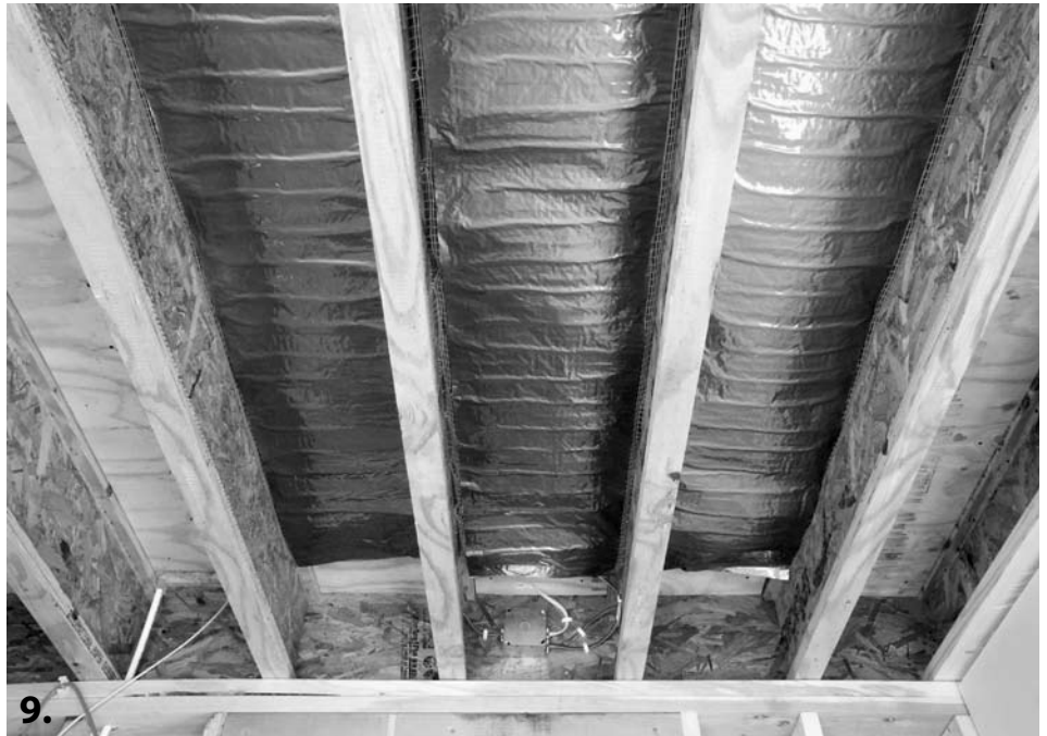
6. En el otro extremo de la placa, coloque un clavo en la viga a 2" por debajo del suelo falso. Cuelgue la malla de fibra de la placa en el clavo. Esto hará mucho más fácil engrapar el resto de la placa.
