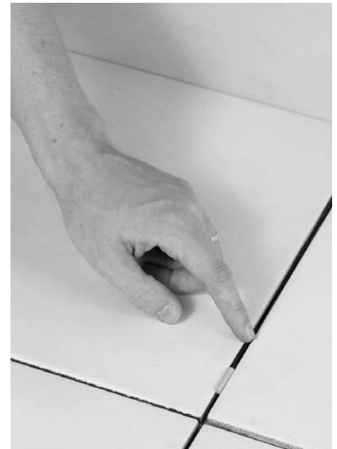
Método 3: Retire la línea de lechada 1/4" a 1/2" de profundidad. Instale el sensor. Vuelva a colocar la línea de lechada sobre el sensor y cable del sensor.
