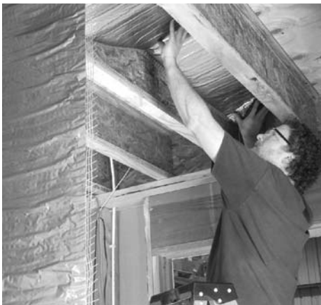
Pruebe encajar la placa entre las vigas antes de sujetar la placa a ellas con ayuda de grapas.
